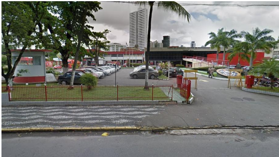
Figura 11 - Quartel do Comando Geral, 2ª Seção de Bombeiros de Incêndio.
