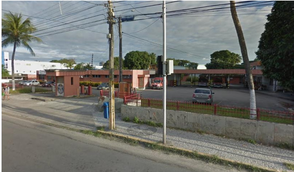
Figura 10 - Grupamento de Bombeiros de Incêndio.
