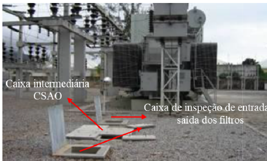
Figura 8 - Caixas de inspeção de entrada e saída dos fluídos e a caixa intermediária onde fica a caixa separadora de água e óleo fabricada com fibra de vidro.
