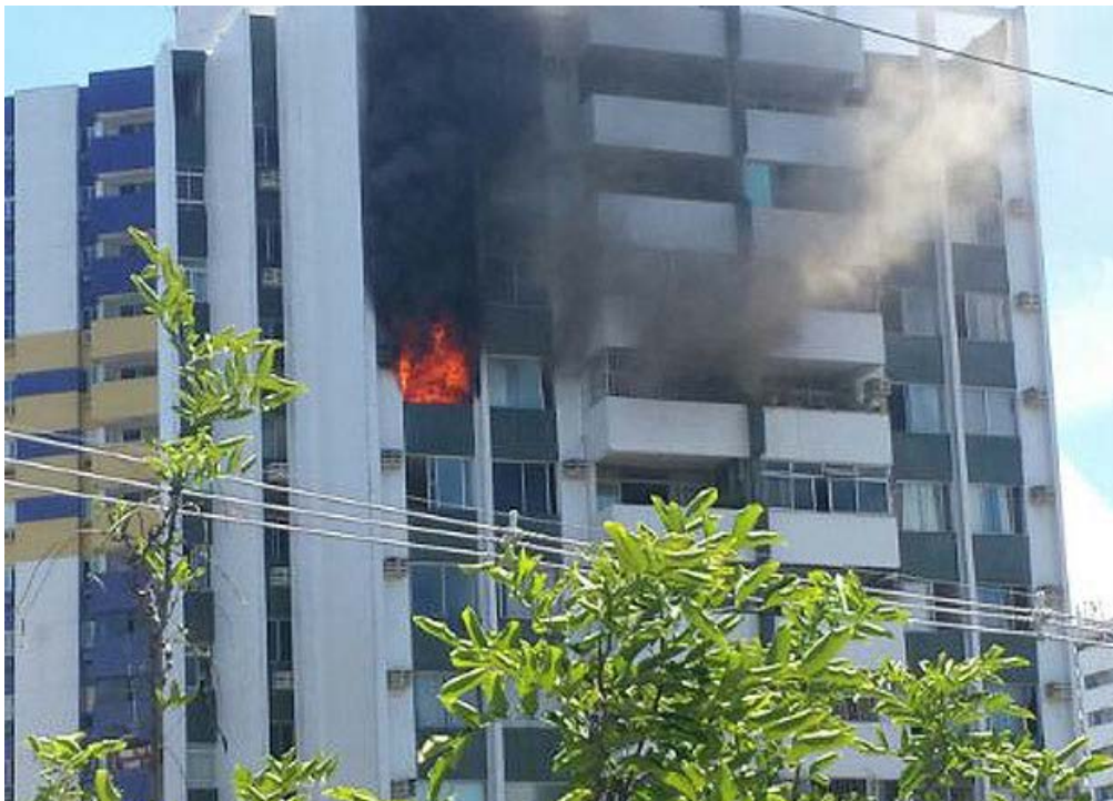
Fotografia 3 – Incêndio no ap. 902 com reflexo nos apto. 802, 1.002 e 1.102
