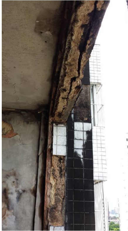
Fotografia 15 – Capiços da janela e cerâmica da fachada
