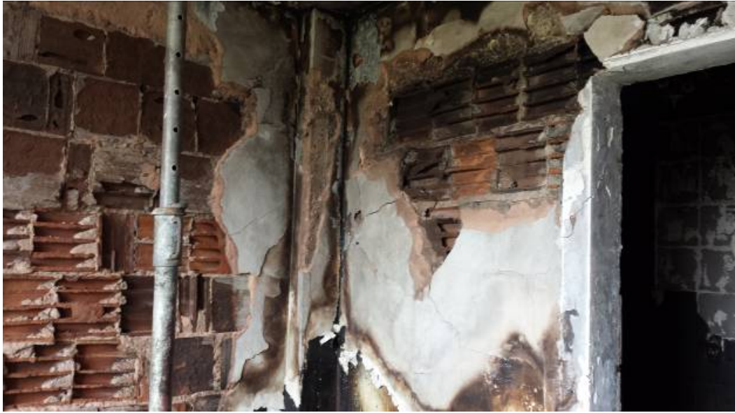
Fotografia 5 – Parede divisória do banheiro
