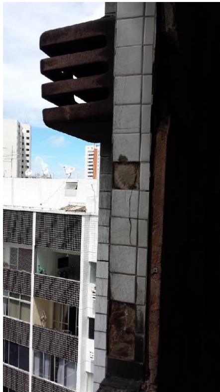
Fotografia 14 – Capiços da janela e cerâmica da fachada
