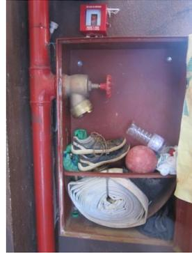
Figura 2: Hidrante pavimento tipo.
