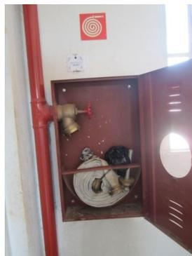
Figura 6: Hidrante pavimento tipo.
