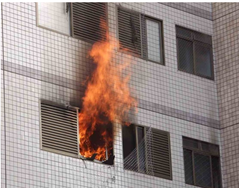
Figura 4 – Visão do incêndio pelo exterior do prédio
